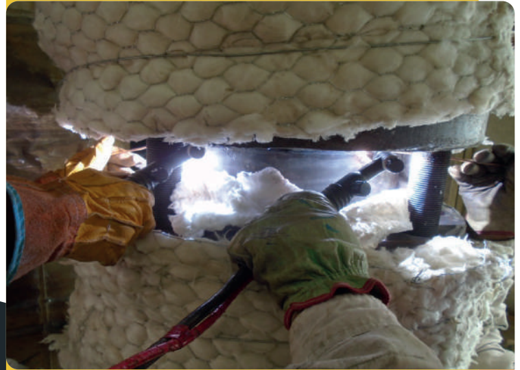
APLICACIÓN DE SOLDADURA EN MATERIAL P-22 DE VAPOR DE 110KG/CM2
