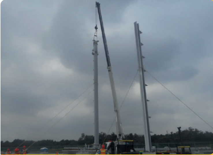
CONSTRUCCIÓN DE NAVES INDUSTRIALES
