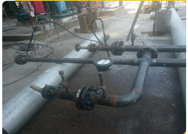
FABRICACIÓN DE TUBO DE 4" DE DIAMETRO
