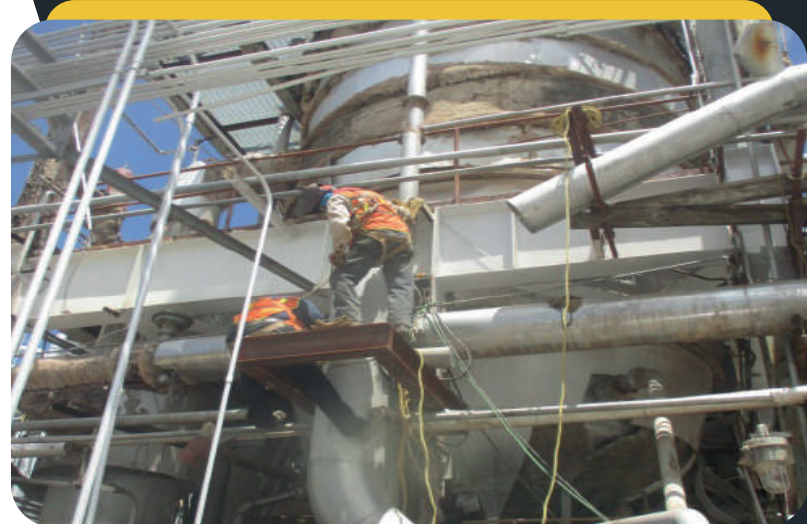
MONTAJE DE LINEAS DE ACERO INOXIDABLE DE VARIOS TIPOS DE DIAMETROS A PROYECTO DE GRANO CRECIDO
