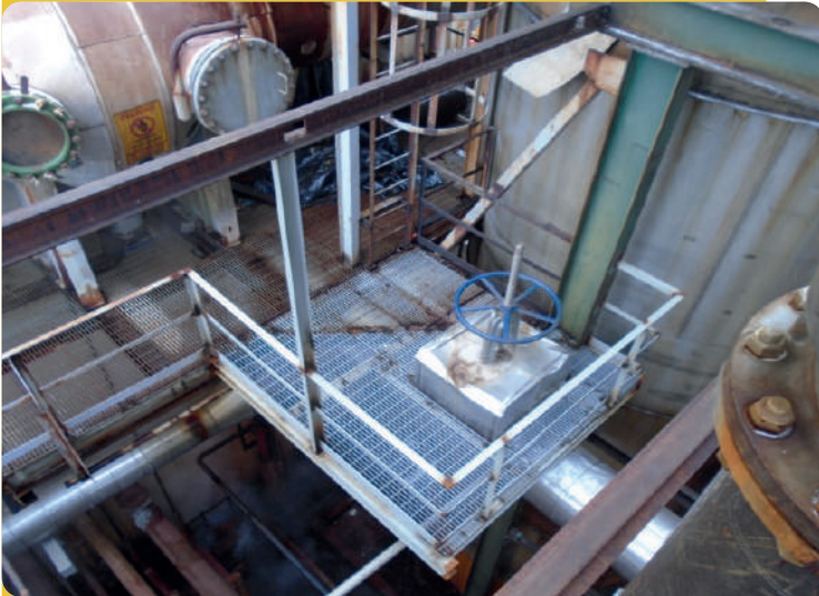
FABRICACIÓN DE PLATAFORMAS PARA VALVULAS DE COGENERACIÓN
