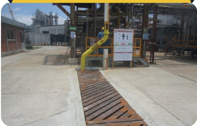
TUBERÍA DE 600 MTS DE 8" DE DIAMETRO A.C. CED. 80 INSTALADA
