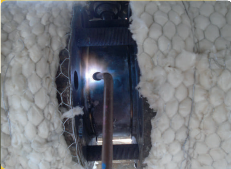
APLICACIÓN DE SOLDADURA EN MATERIAL P-22 DE VAPOR DE 110KG/CM2
