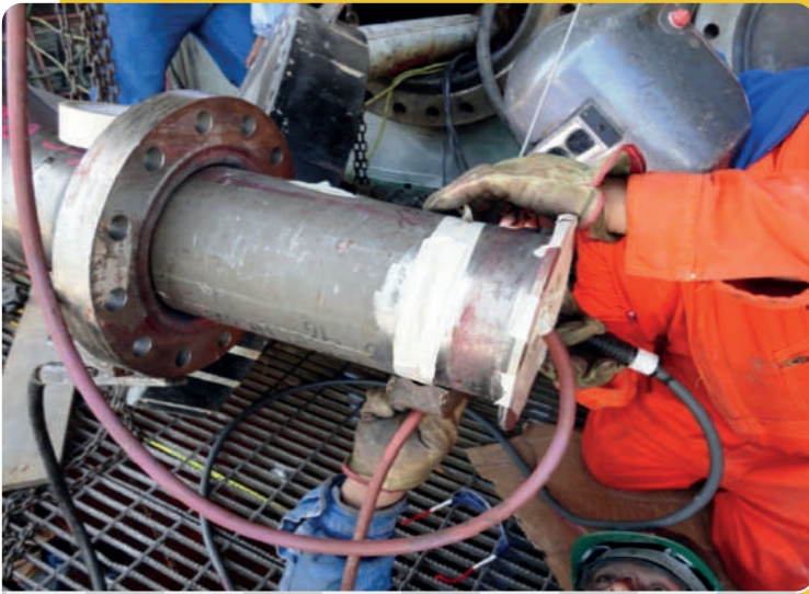
FABRICACIÓN DE LINEAS DE REFLUJO DE 6" DE DIAMETRO DE TITANIO
