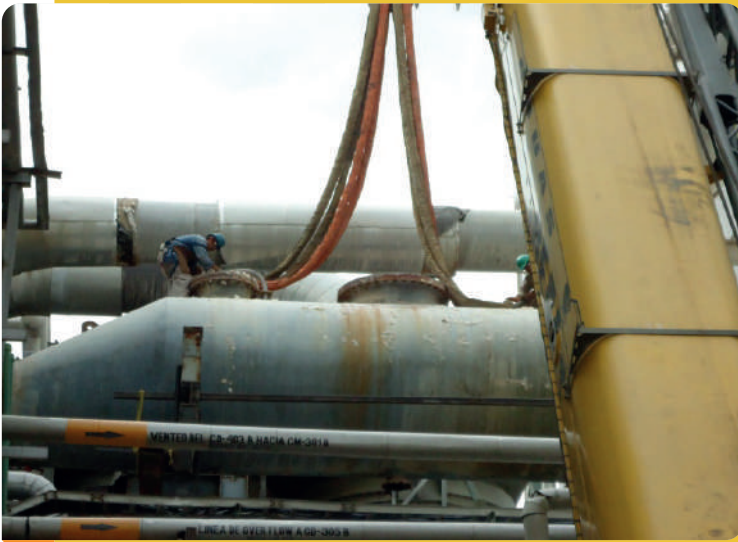
DESINSTALACIÓN DE ANTIGUO KETTLE CE-320
