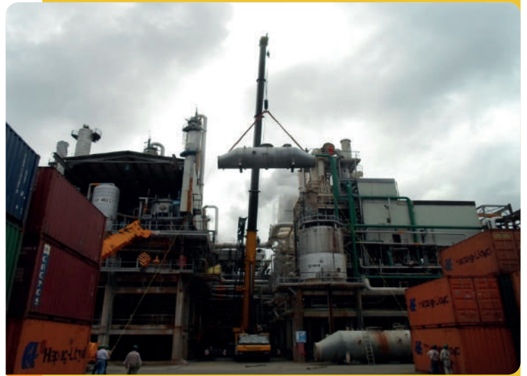
DESMONTAJE DE ANTIGUO KETTLE CE-320
