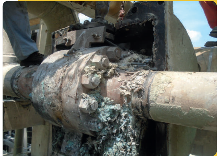
RETIRO DE ENCAPSULADO, CAMBIO DE ANILLOS EN BRIDAS DE 10" DE DIAMETRO 1500#
