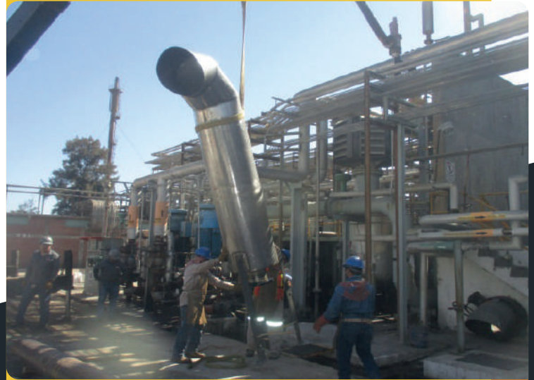
MONTAJE DE SILENCIADOR K-521
