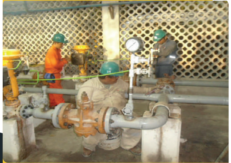
CAMBIO DE LINEA DE 4" DE DIAMETRO DE LA CASETA DE GASTA NATURAL.
