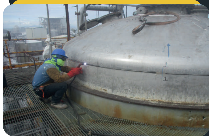
CAMBIO DE INTERNOS Y AGITADOR DEL EQUIPO S-906, PROYECTO GRANO CRECIDO
