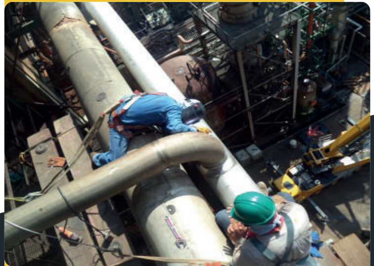
CAMBIO DE CABEZAL DE SALIDA DE VENTEOS DE REACTORES BR-301/3
