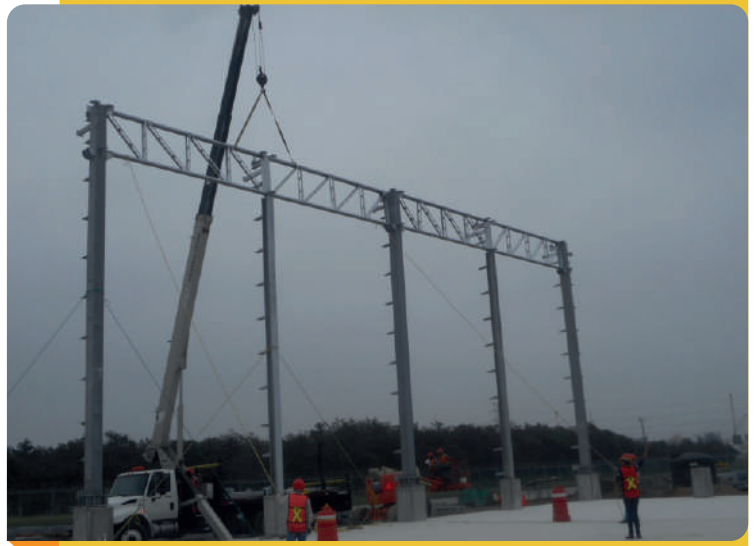
CONSTRUCCIÓN DE NAVES INDUSTRIALES
