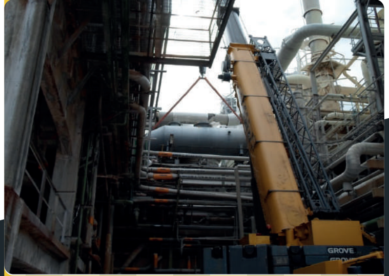
INSTALACIÓN DE NUEVO KETTLE CE-320
