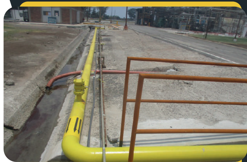
TUBERÍA DE 600 MTS DE 8" DE DIAMETRO A.C. CED. 80 INSTALADA
