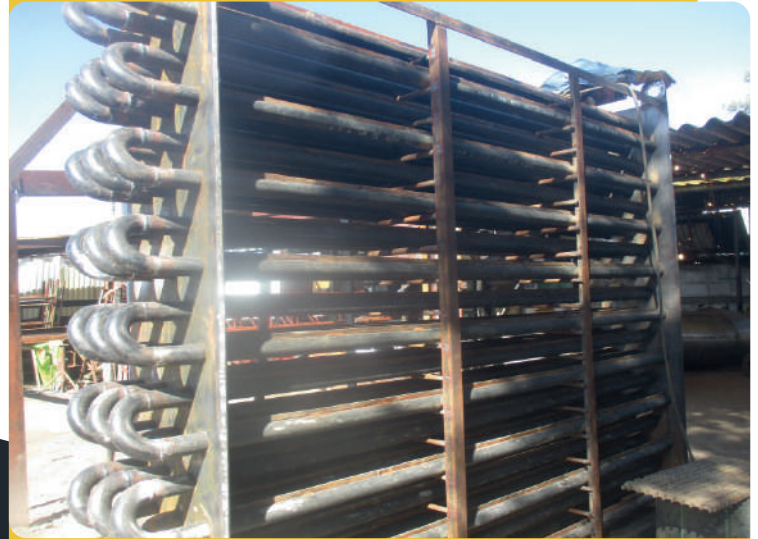
CAMBIO DE FLUXERIA EN EQUIPO E-212
