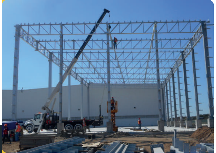
CONSTRUCCIÓN DE NAVES INDUSTRIALES
