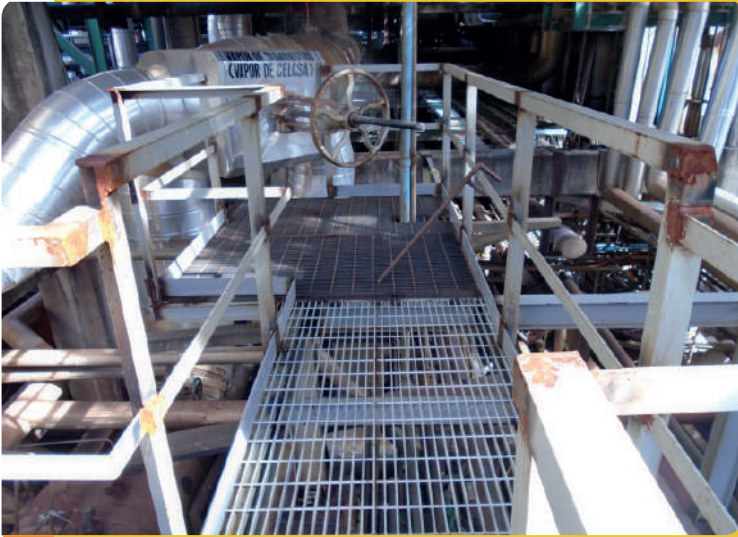
FABRICACIÓN DE PLATAFORMAS PARA VALVULAS DE COGENERACIÓN
