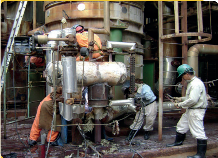
REPARACIÓN DE LINEAS DE SALIDA DE CONDENSADOS DEL REBOILER BE-700
