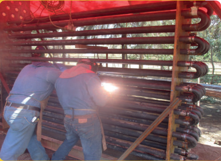
CAMBIO DE FLUXERIA EN EQUIPO E-212
