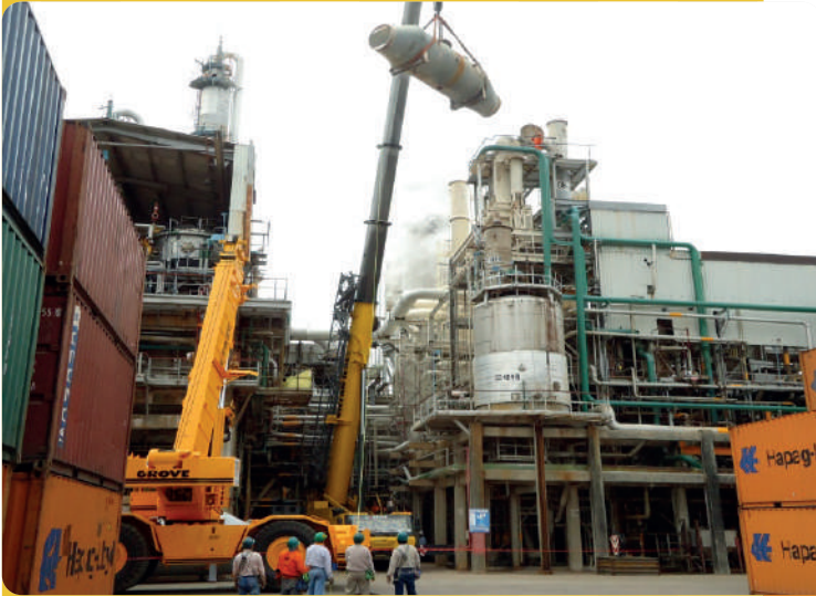
MONTAJE DE NUEVO KETTLE CE-320
