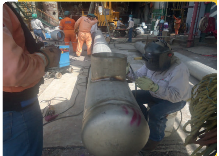
FABRICACIÓN DE CABEZAL DE SALIDA DE VENTEOS
