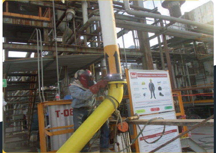
FABRICACIÓN DE TUBERÍA DE 600 MTS DE 8" DE DIAMETRO A.C. CED. 80.
