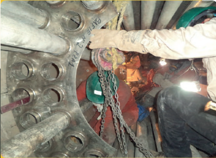
CAMBIOS DE 2 BAFLES Y REPOSICIÓN DE 20 TUBOS EN SECADOR BM-513
