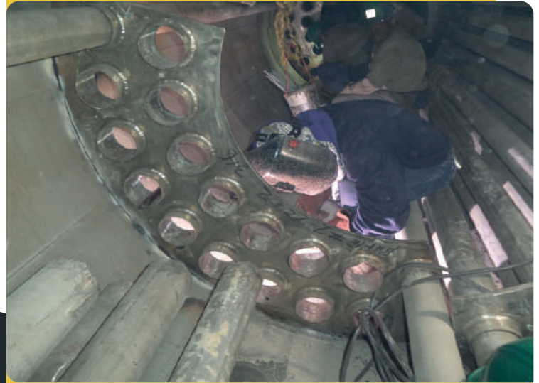
CAMBIOS DE 2 BAFLES Y REPOSICIÓN DE 20 TUBOS EN SECADOR BM-513
