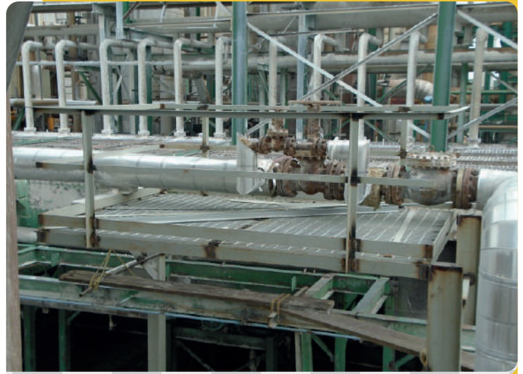
FABRICACIÓN DE PLATAFORMAS PARA VALVULAS DE COGENERACIÓN
