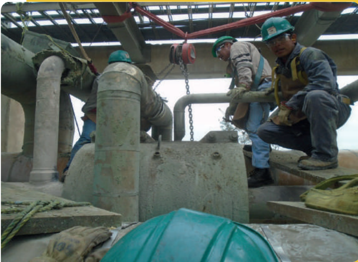
RETIRO DE ENCAPSULADO, CAMBIO DE ANILLOS EN BRIDAS DE 10" DE DIAMETRO 1500#
