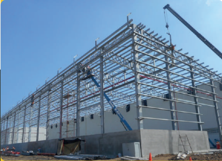
CONSTRUCCIÓN DE NAVES INDUSTRIALES
