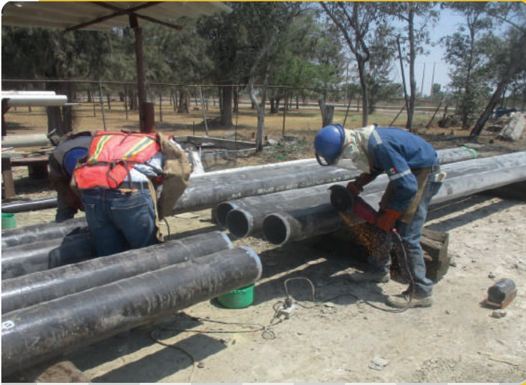
FABRICACIÓN DE TUBERÍA DE 600 MTS DE 8" DE DIAMETRO A.C. CED. 80.
