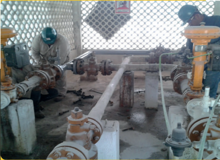
CAMBIO DE LINEA DE 4" DE DIAMETRO DE LA CASETA DE GASTA NATURAL.
