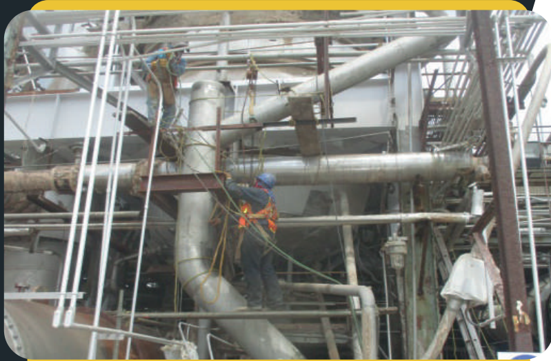
MONTAJE DE LINEAS DE ACERO INOXIDABLE DE VARIOS TIPOS DE DIAMETROS A PROYECTO DE GRANO CRECIDO
