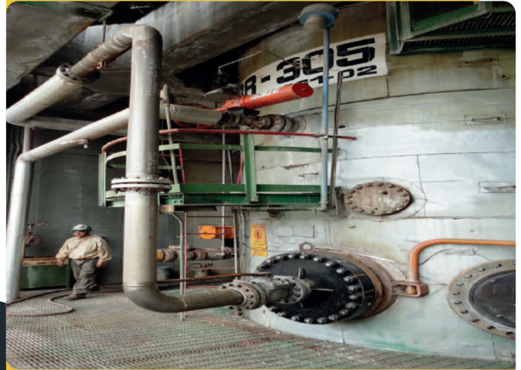
INSTALACIÓN DE LINEA DE REFLUJO A LOS REACTORES BR-305 Y BR-307
