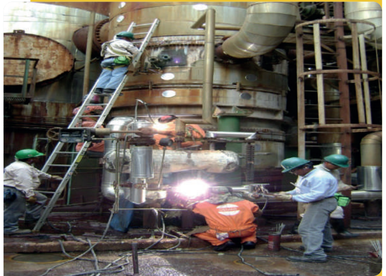
REPARACIÓN DE LINEAS DE SALIDA DE CONDENSADOS DEL REBOILER BE-700
