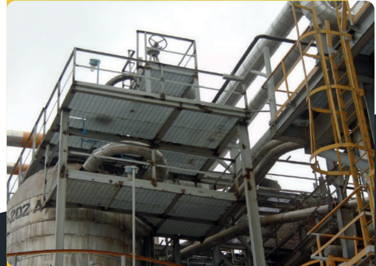
FABRICACIÓN DE PLATAFORMAS PARA VALVULAS DE COGENERACIÓN
