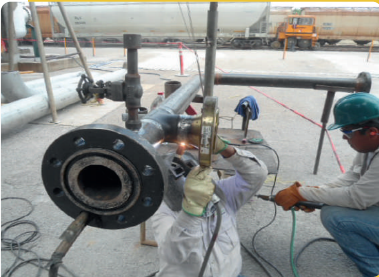
FABRICACIÓN DE TUBO DE 4" DE DIAMETRO
