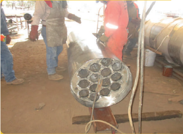
MONTAJE DE SILENCIADOR K-521
